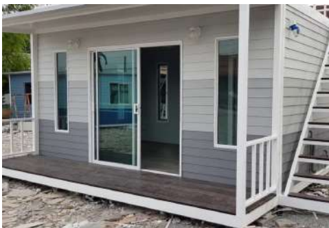
บ้านประกอบเสร็จ
